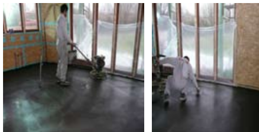
Polieren (vlinderen) van het betonoppervlak met helikopter, manuele retouches.
