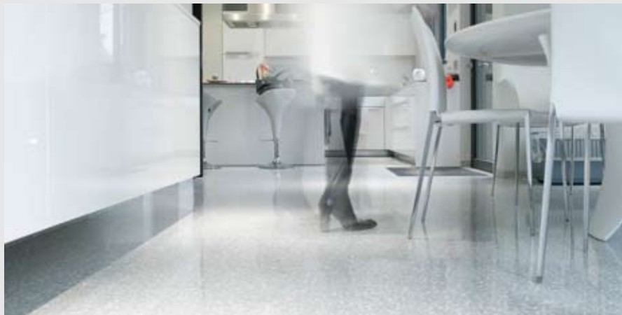
Vloer in granito (terrazzo) : de 10 tot 15 mm dikke afwerkingslaag bevat gebroken marmerscherven arch. S. Roose © A. Nullens
