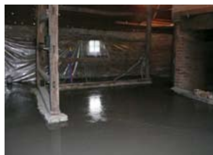
Op niveau brengen van het beton, controle met laser.
