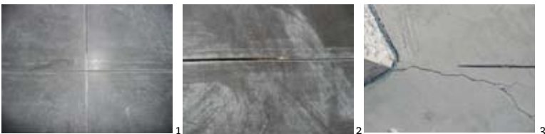
1 en 2 - Gezaagde voegen 3 - Willekeurige scheur tussen voeg en vast punt
