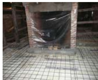
Omtrekvoeg en bescherming tegen opspattend beton
